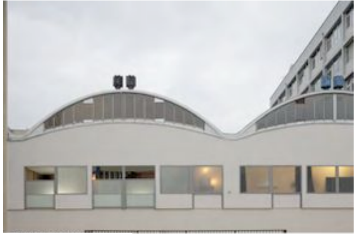
FACADE APRES TRAVAUX
